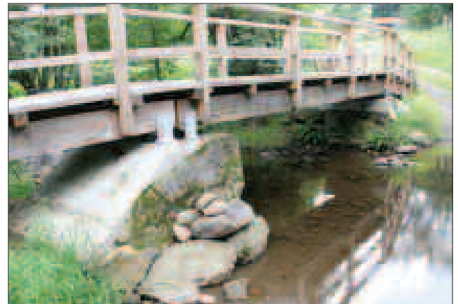
Neue Holzträger für den Erlensteg
