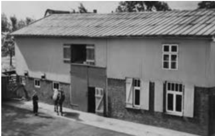
Von Scheune und Stall...
