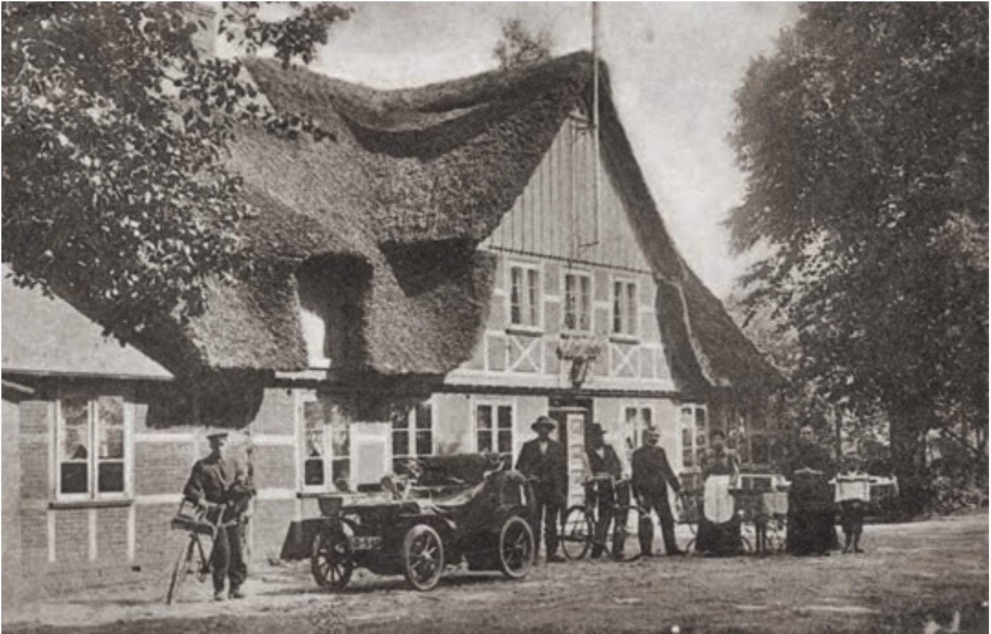
Das Gasthaus von Funk, Wriede, am Schüttdamm bzw. Oben-Altendorf mit Strohbedeckung
